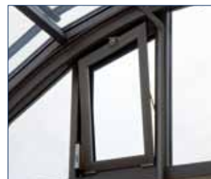
Системы фрамужных открывателей в комбинации с линейными электроприводами
